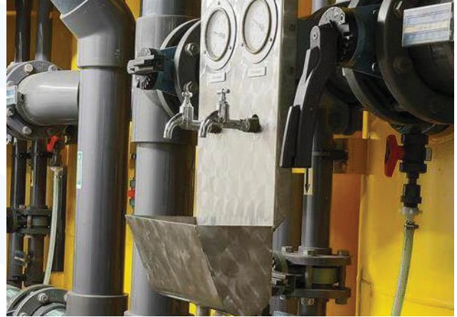
Undichtigkeiten in der über 30 Jahre alten Filteranlage
