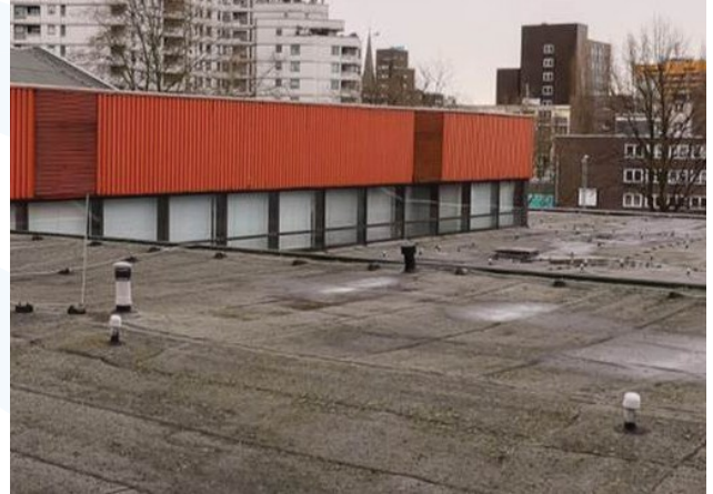
Die riesige Dachfläche ist sanierungsbedürftig
