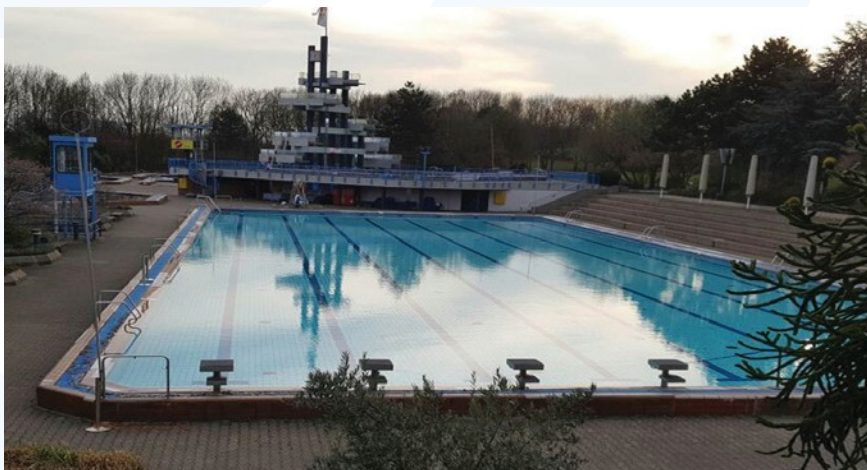
Beckenschiefelage durch bergbaubedingte Einwirkungen
