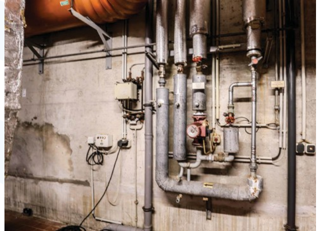
Heizungsinstallation ist sanierungsbedürftig
