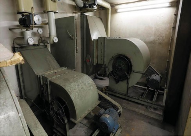
Lüftungsanlage unter energetischen Gesichtspunkten völlig veraltet
