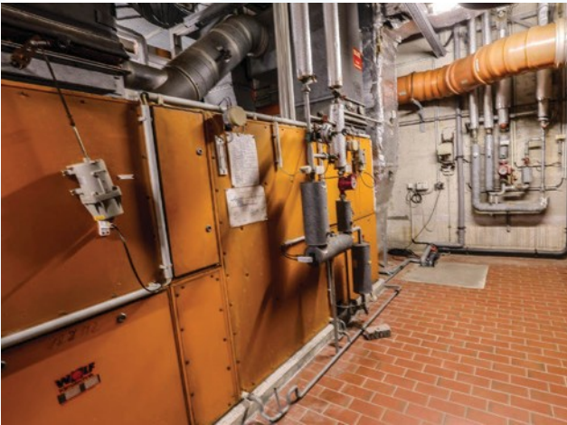
Lüftungsanlagen z. T. technisch abgängig
