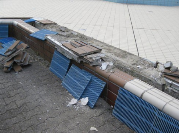
Hoher bautechnischer Sanierungsaufwand vor jeder Freibaderöffnung
