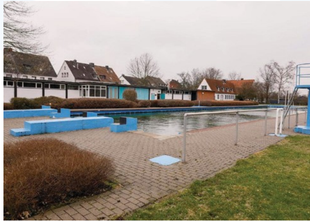
Gebäude und Beckenkörper veraltet und schadensanfällig
