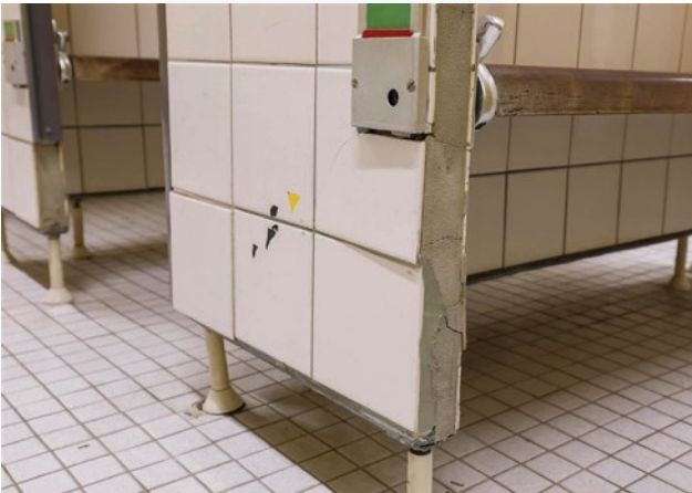
Umkleidekabinen im Erdgeschoss mit starken baulichen Schäden
