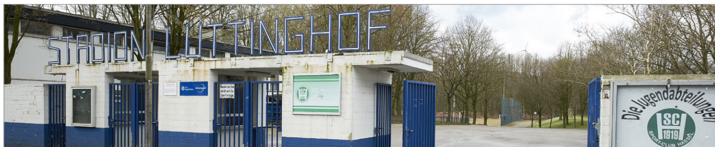
Eingangsbereich der Sportanlage Lüttinghof in Hassel
