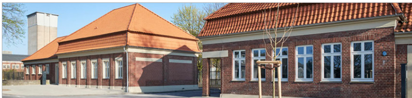
Die fertig umgebauten Torhäuser an der Egonstraße 10 und 12
