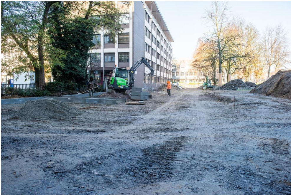
Abb.2: Arbeiten vor dem ehemaligen Versorgungsamt (Quelle: Caroline Seidel)
