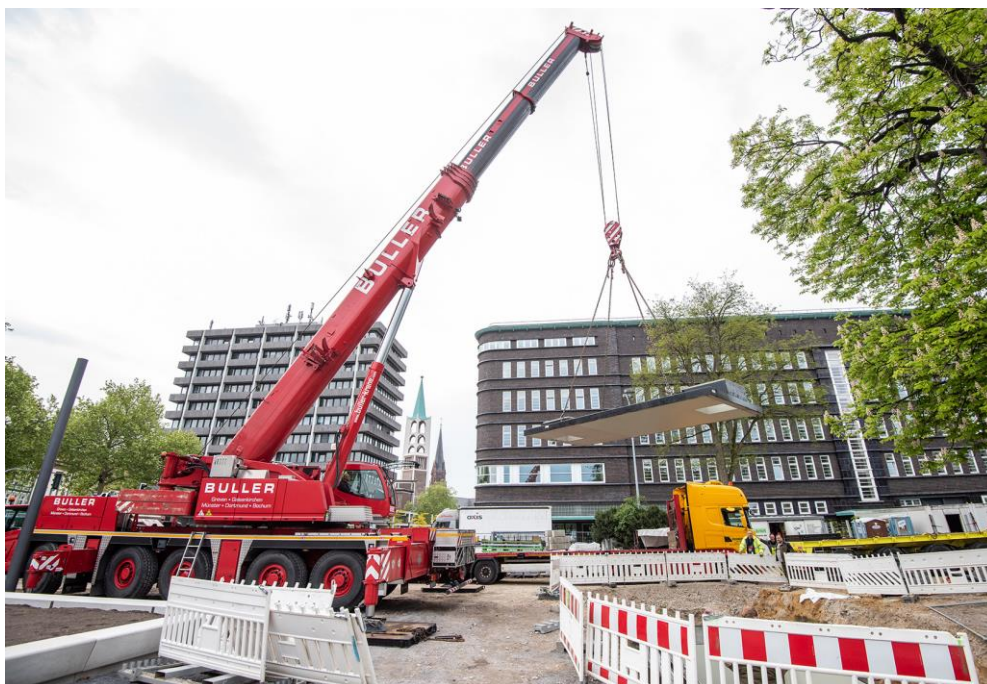
Abb.2: Einbau Technischacht Fontänenfeld (Quelle: Caroline Seidel)
