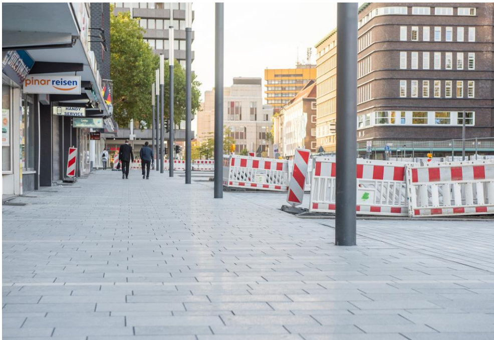
Abbildung 2: Neue Pflasterung des Gehwegs (Quelle: Caroline Seidel)
