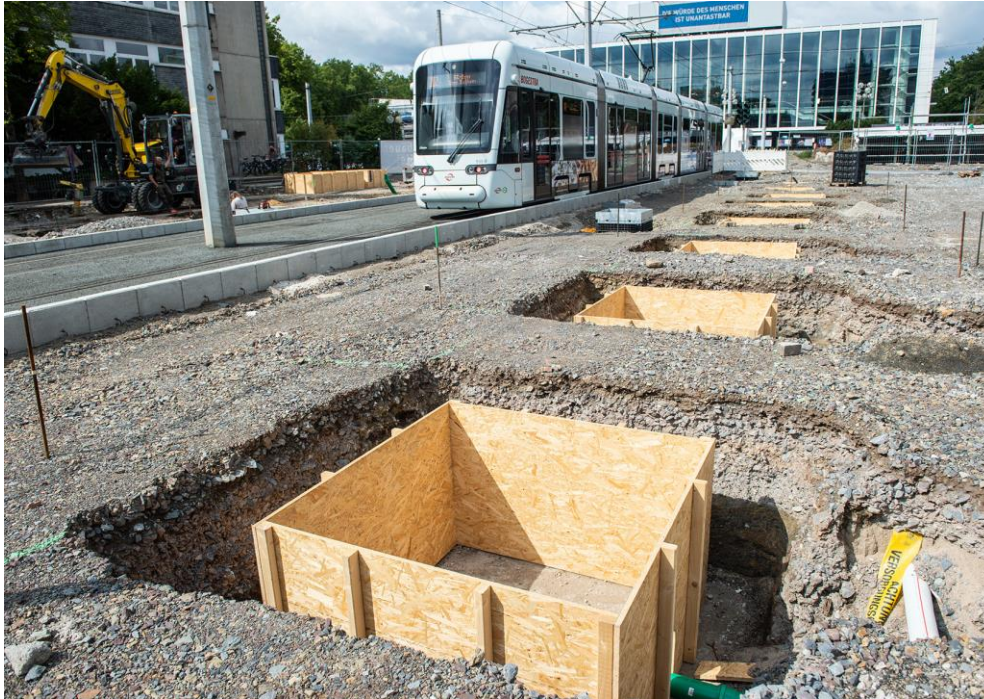
Abbildung 3: Vorbereitende Arbeiten für die neuen Haltstellendächer (Quelle: Caroline Seidel)
