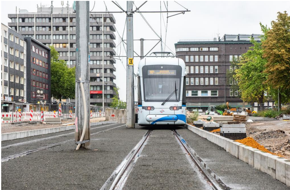
Abbildung 3: Der erneuerte Gleisbereich (Quelle: Caroline Seidel)
