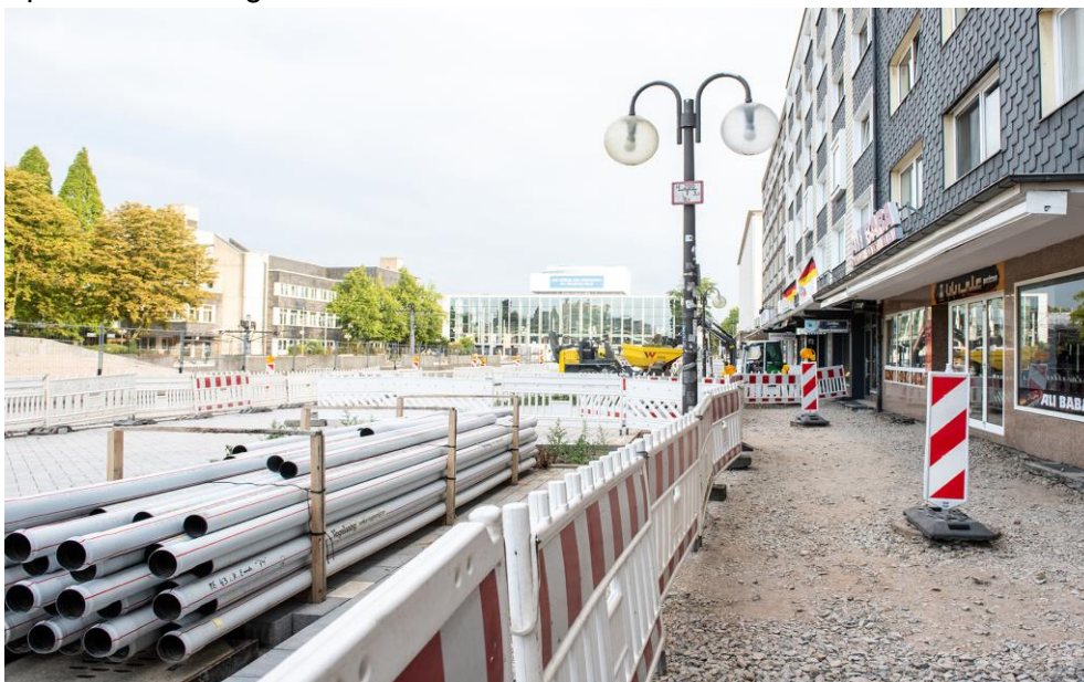
Abbildung 1: Erneuerung des Gehwegs (Quelle: Caroline Seidel)
