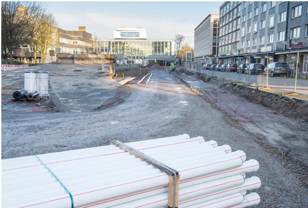
Abbildung 2: Herstellung der provisorischen Fahrbahn an der Ebertstraße und Leerrohre für zukünftige Leitungen (Quelle: Stadt Gelsenkirchen)
