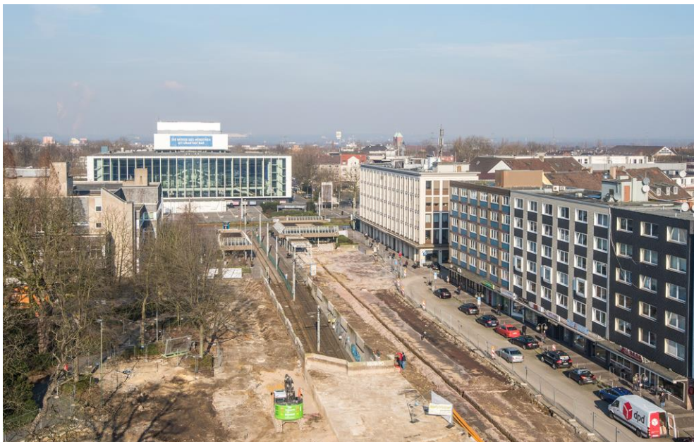
Abbildung 1: Übersicht des Baustellenbereichs (Quelle: Stadt Gelsenkirchen)
