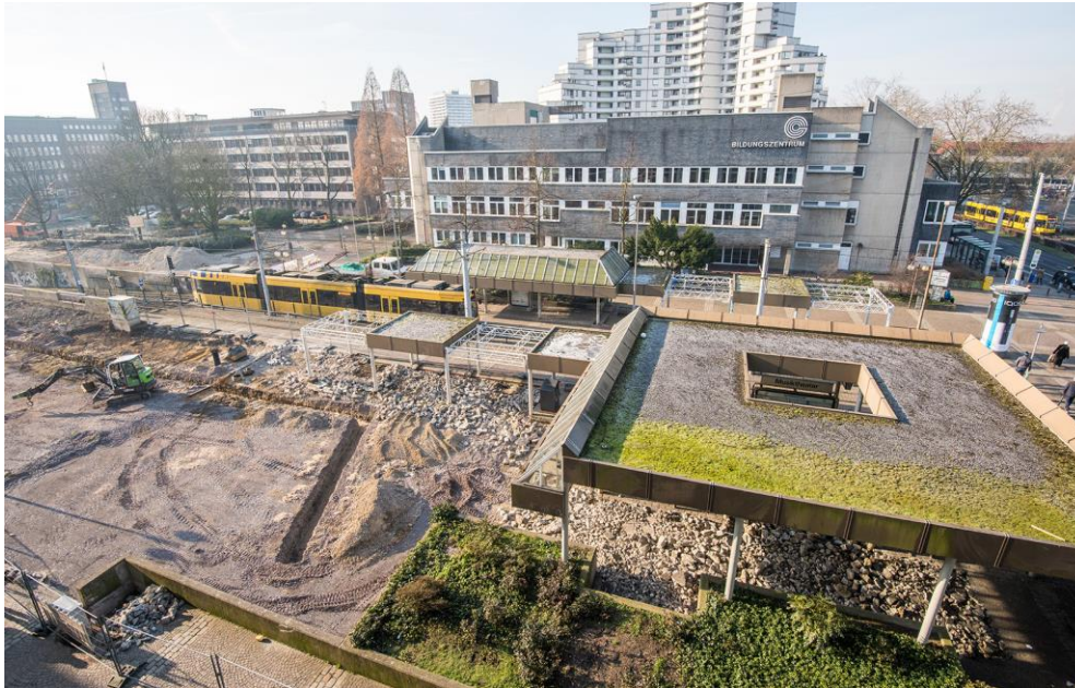
Abbildung 3: Arbeiten vor dem ELE-Gebäude (Quelle: Stadt Gelsenkirchen)
