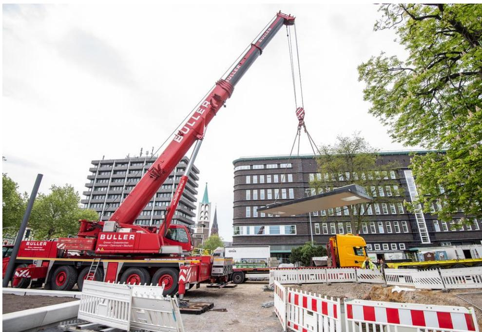
Abb.2: Einbau Technischacht Fontänenfeld (Quelle: Caroline Seidel)
