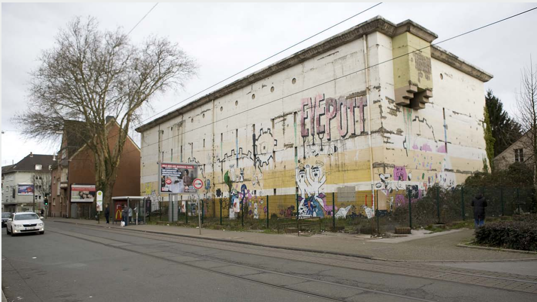
Der Bunker an der Bochumer Straße Bildrechte: Stadt Gelsenkirchen
