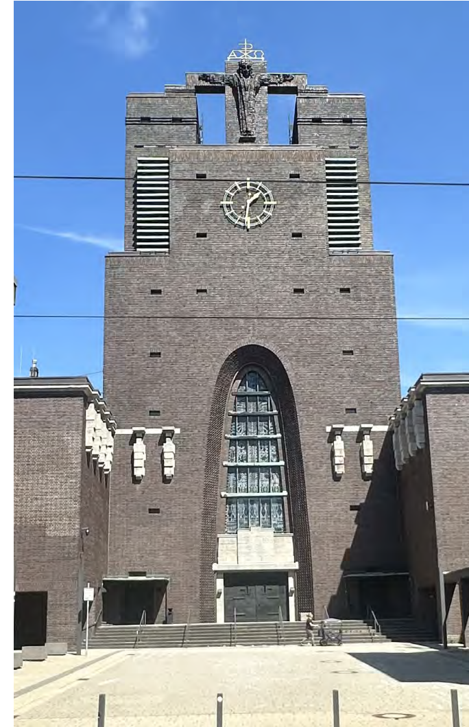
Die Heilig-Kreuz-Kirche wurde aufwändig saniert.
