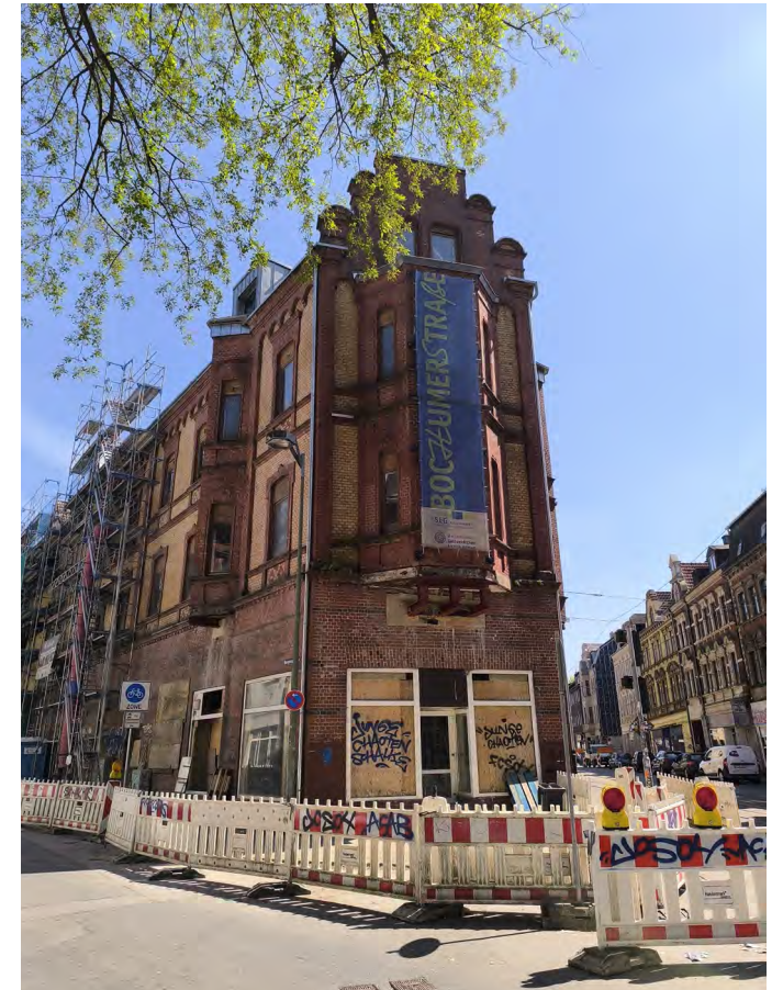
Bochumer Straße 99 / Bergmannstraße 2: derzeit im Umbau.
