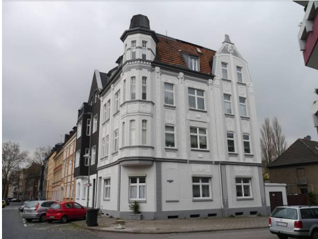
Foto 1: Sanierte Gebäudefassade an der Franz-Bielefeld-Straße
