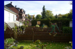
Gebäude mit Mietergärten
