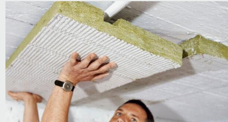
Abbildung 1 Dämmung einer Kellerdecke (Bild: dena)
