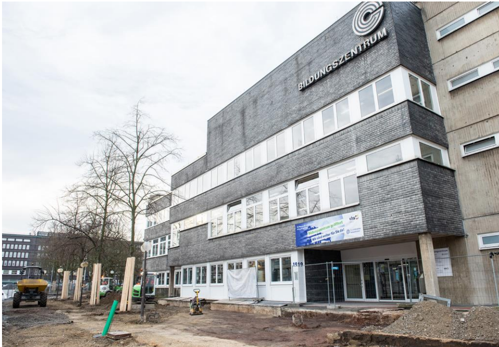
Abbildung 3: Arbeiten vor dem Bildungszentrum (Quelle: Caroline Seidel)
