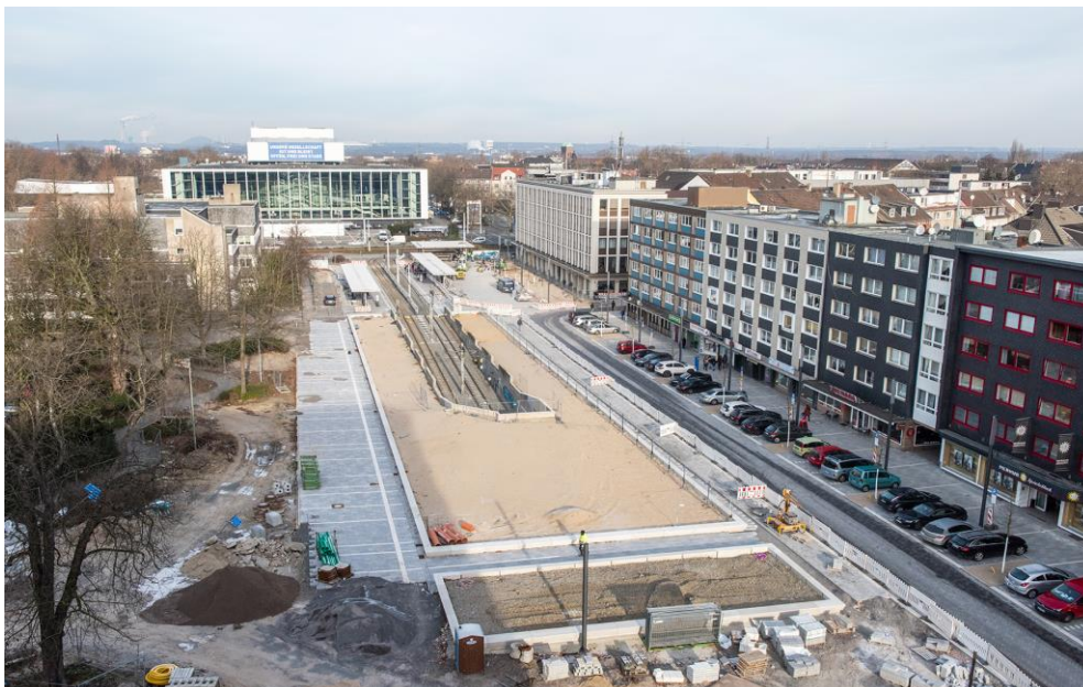
Abbildung 1: Blick über die Baustelle von Ende Januar (Quelle: Caroline Seidel)
