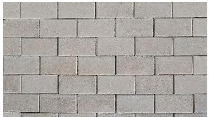
Abb. 27: Pflasterung Mischverkehrsfläche
