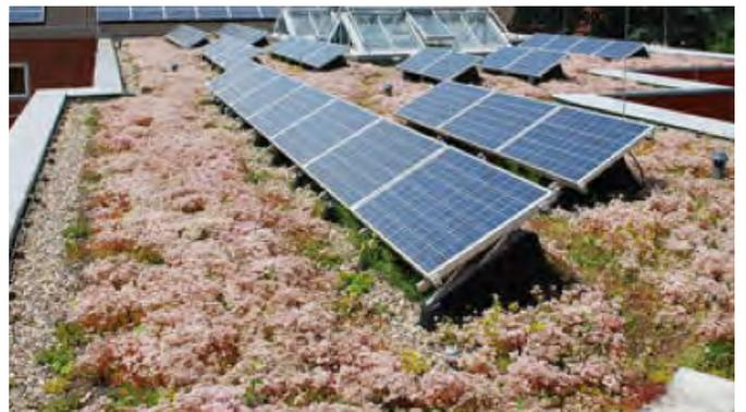
Abb. 106: Solarkollektoren auf einem Gründach
