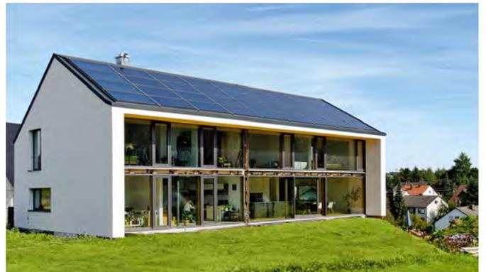
Abb. 105: Solarkollektoren auf einem Satteldach
