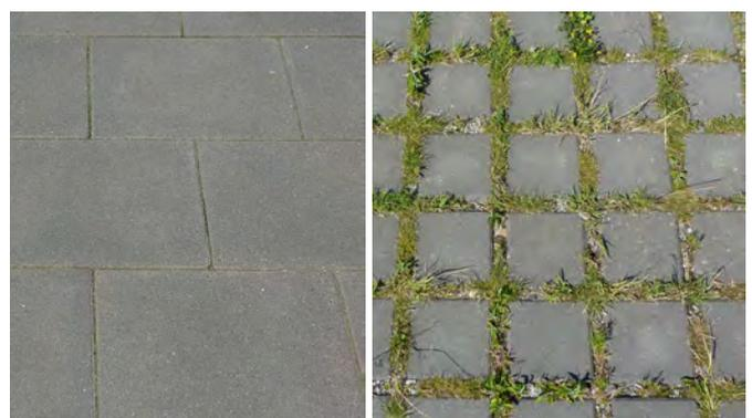
Abb. 28: Pflasterung Gehweg / Rasenfugenpflaster
