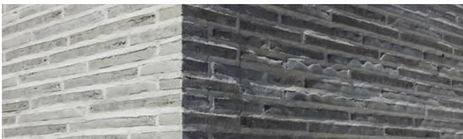
Abb. 89: Verblendmauerwerk
