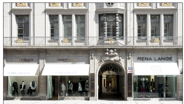
Markisen sollen die Elemente der Fassadengliederung nicht verdecken.
