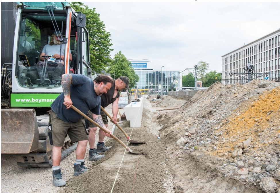
Abbildung 3: Aufbau der ersten Sitzmauern (Quelle: Caroline Seidel)
