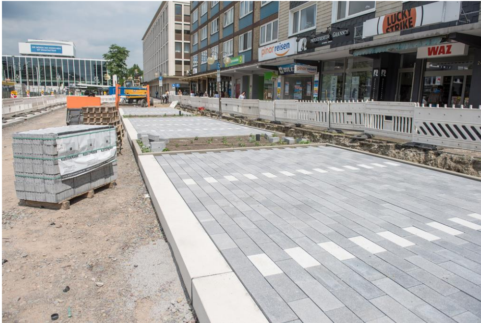
Abbildung 2: Bereits gepflasterte Parkplätze und dazwischenliegende Baumgruben (Quelle: Caroline Seidel)
