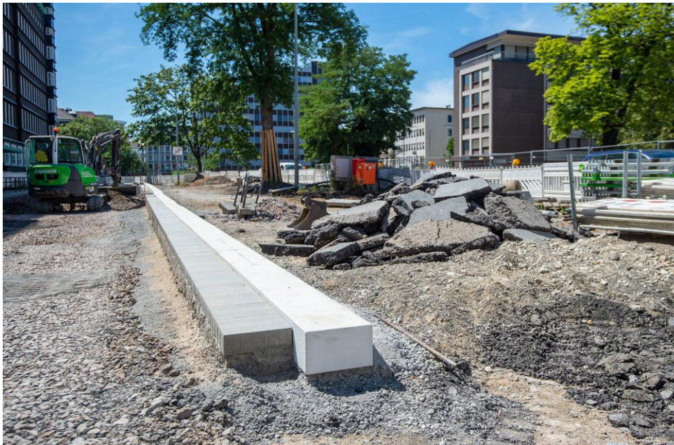
Abb. 3: Arbeiten auf der Vattmannstraße (Quelle: Caroline Seidel)
