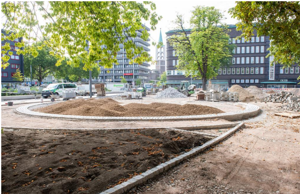
Abb. 2: Bau der neuen Wege und Spielflächen im Parkbereich (Quelle: Caroline Seidel)
