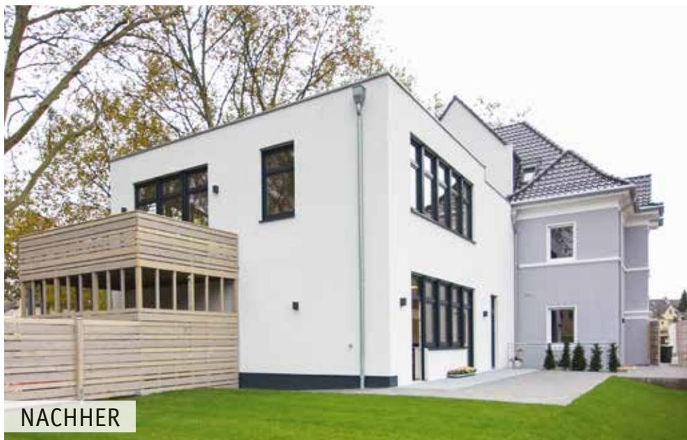
niert“, erklären die Architekten. An seine Stelle setzten die Planer einen neuen rund 330 m<sup>2</sup> großen Anbau über drei Etagen, inklusive Keller. Dieser wurde nach geltender Energieeinsparverordnung sinnvoll mit einem 16 cm starken Wärmedämmverbundsystem verkleidet. Energieeffiziente Fenster
