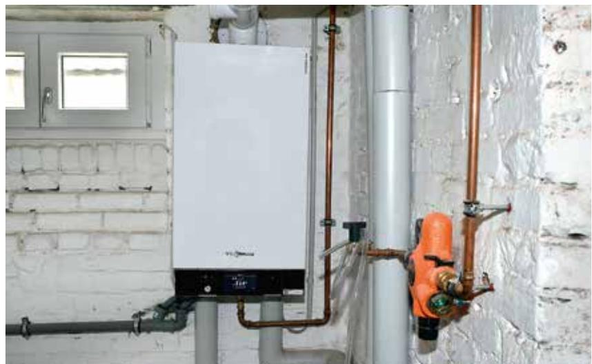
Die neue Gas-Heizung ersetzt die alten Kohleöfen und versorgt das Zechenhaus nun zentral mit Wärme.
