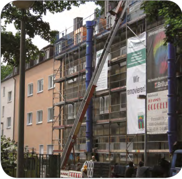
Prinzenstraße 3-9: energetisch modernisiert...
