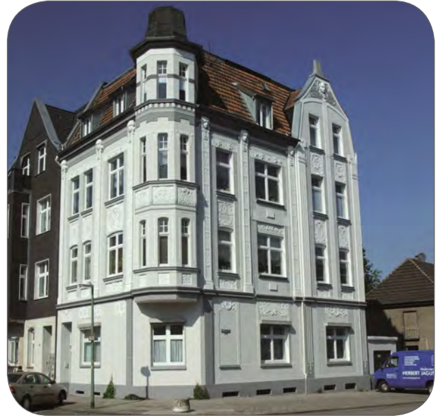
...und nach der erfolgreichen Modernisierung
