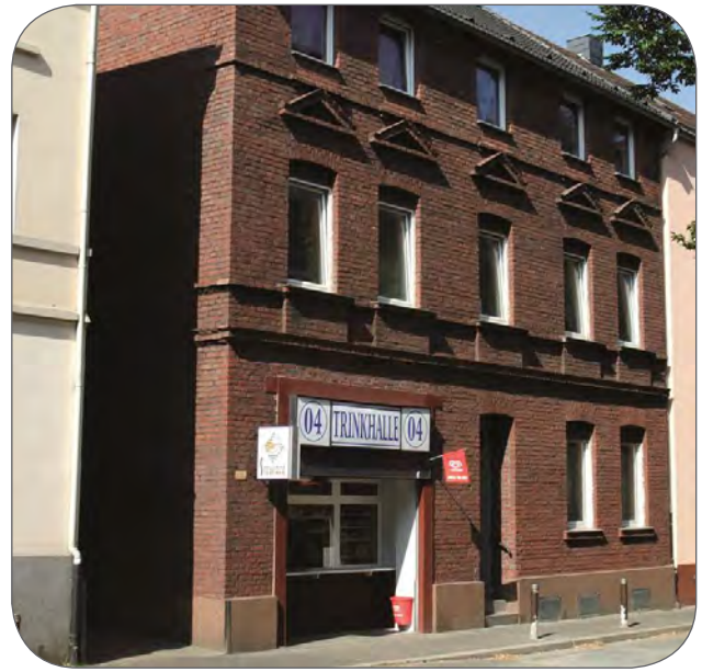
...die Fassade gereinigt und ausgebessert, der Sockel wurde neu gestaltet
