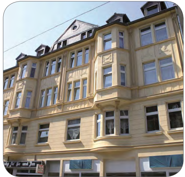
...bereichert nach der Modernisierung das Bild der Schalker Straße
