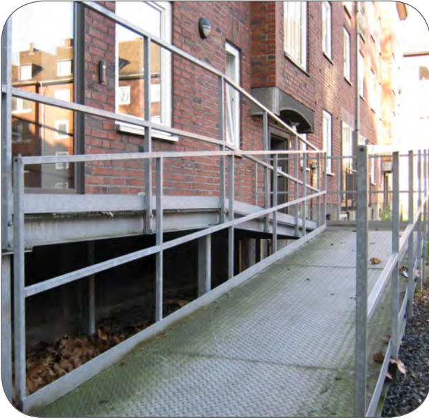
Der barrierefreie Zugang wird durch eine Rampe sichergestellt
