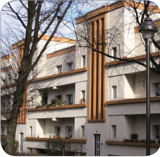
Prägnante Lichtbänder der Treppenhäuser...
