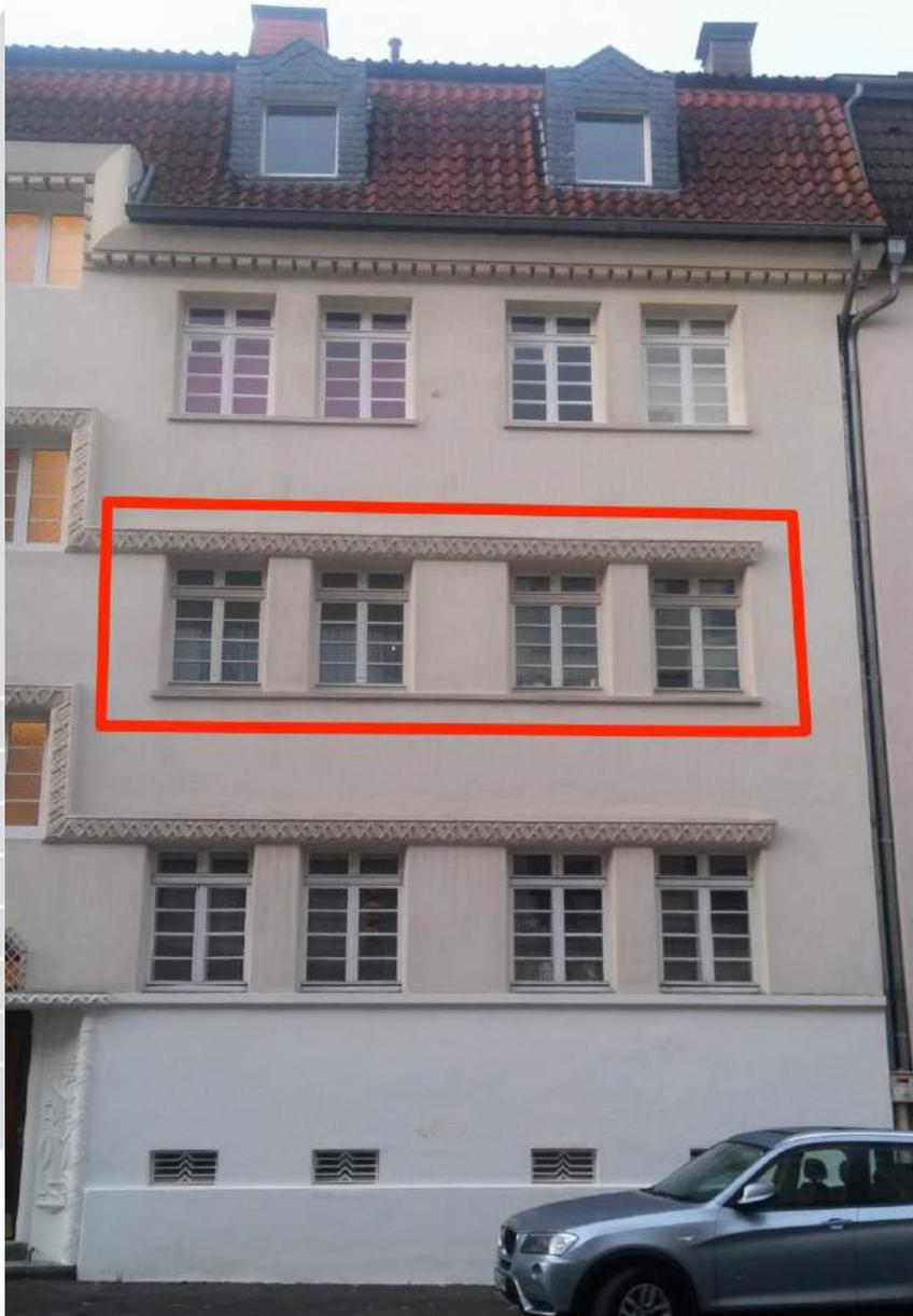
4 Fenster von 12 gleich großen einfachverglasten Holzfenstern einer Fassadenseite müssen ausgetauscht werden, weil sie verzogen und undicht sind.
