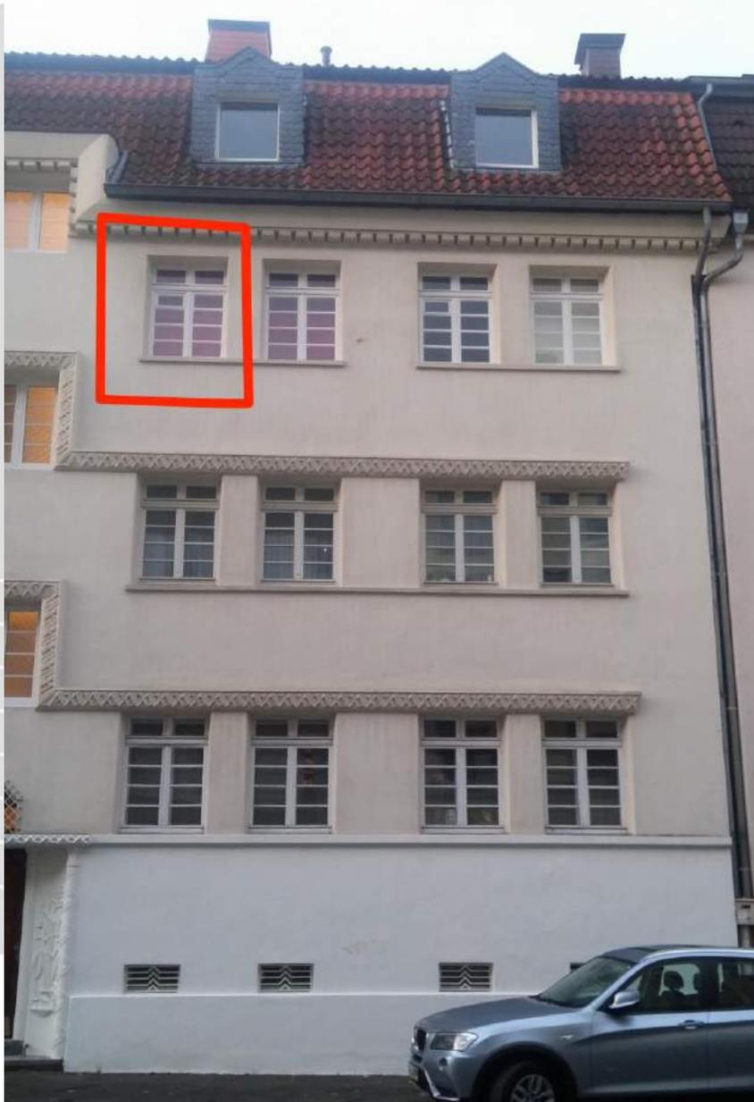
**1 Fenster von 12 gleich großen einfachverglasten Holzfenstern einer Fassadenseite ist verzogen und undicht. Das Fenster kann repariert oder ausgetauscht werden. Beim Austausch muss es nur dem Mindestwärmeschutz entsprechen, da es sich um weniger als 10% der Fenster handelt.**
