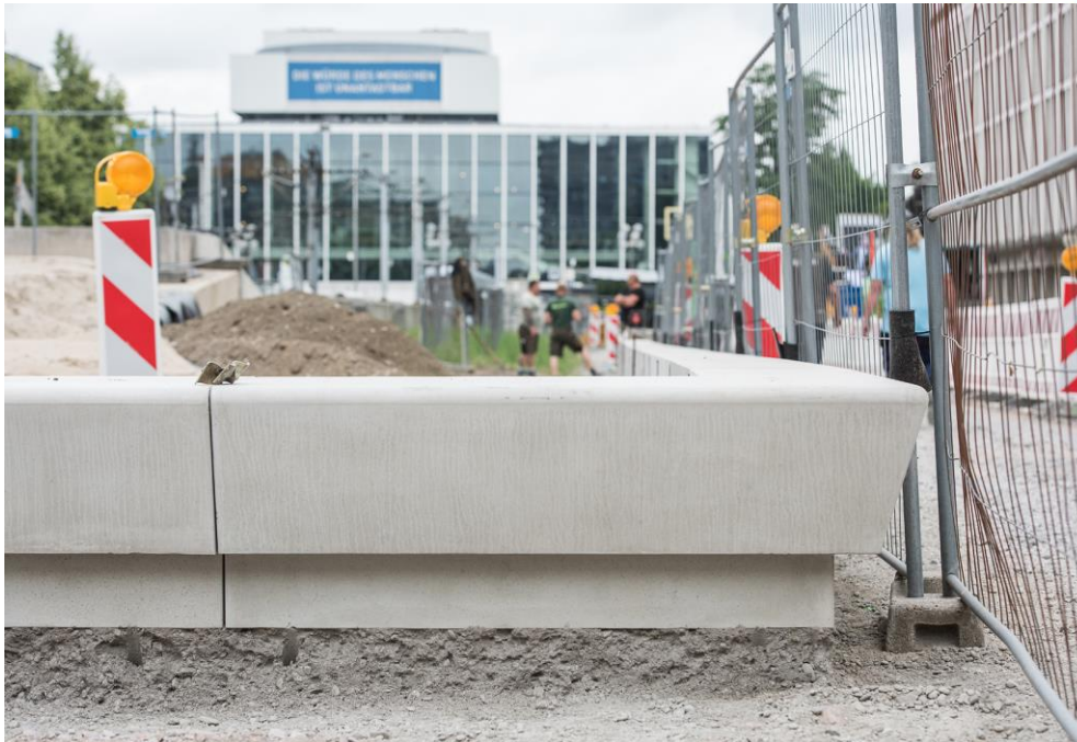
Abbildung 2: Montage der Sitzmauern (Quelle: Caroline Seidel)
