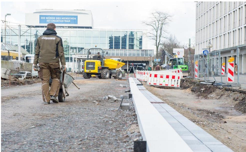
Abbildung 1: Arbeiten an der provisorischen Fahrbahn (Quelle: Caroline Seidel)
