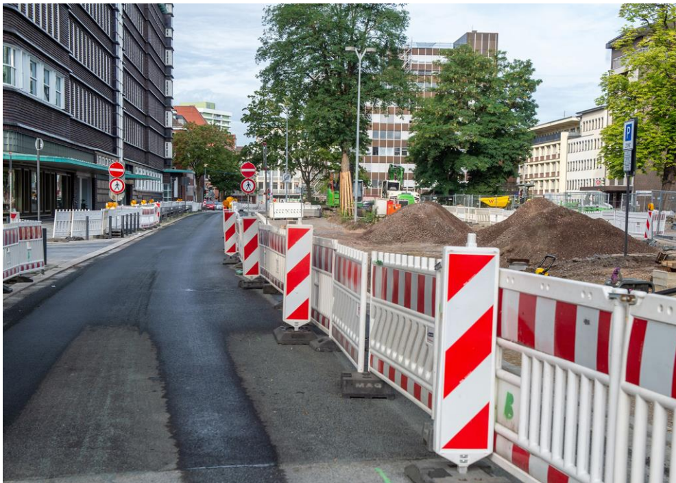
Abb.2: Neue Asphaltoberfläche Vattmannstraße (Quelle: Caroline Seidel)
