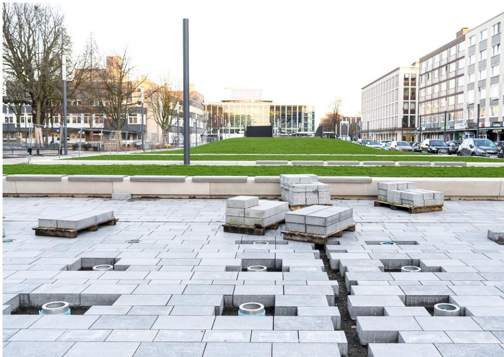
Abb. 1: Arbeiten am neuen Fontänenfeld (Foto: Caroline Seidel)
