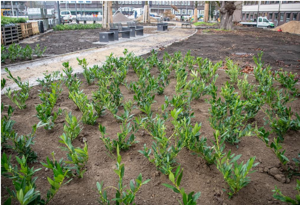
Abb. 3: Pflanzarbeiten im Parkbereich (Foto: Caroline Seidel)
