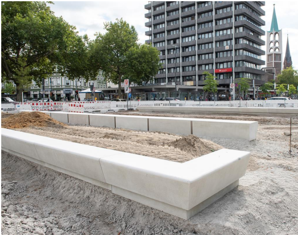
Abb.3: vorbereitende Arbeiten im Bereich des Fontänenfeldes (Quelle: Caroline Seidel)
