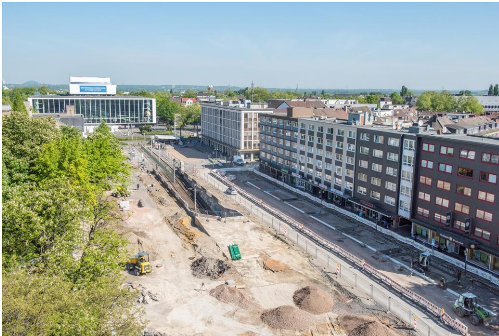
Abbildung 1: Überblick über die Baustelle von Anfang Mai (Quelle: Caroline Seidel)
