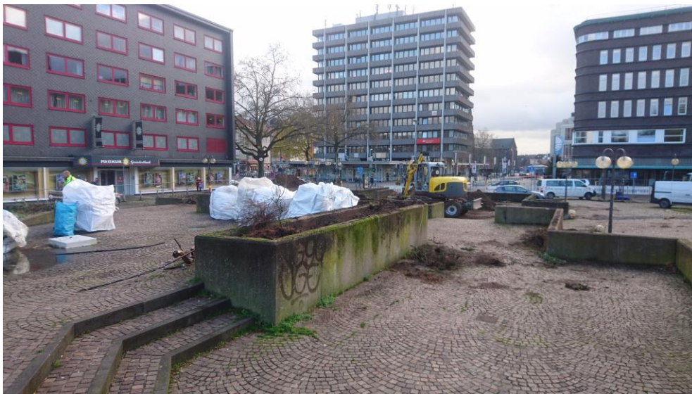
Abb. 2: Rückbau von Hochbeeten und Treppenanlagen (Quelle: Stadtumbaubüro)
