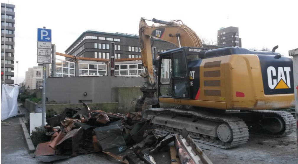
Abb. 1: Rückbau der bluebox mit schwerem Gerät (Quelle: Stadtbaubüro)
