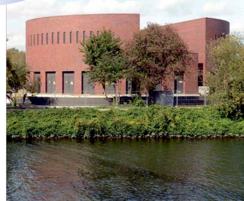
Zwischen Rhein-Herne-Kanal und der Emscher liegt das neue Pumpwerk der Emschergenossenschaft
