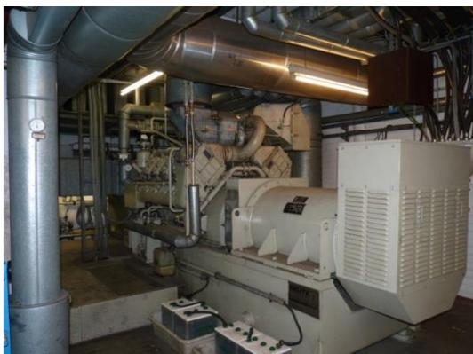
Abbildung 14: Notstromaggregat
