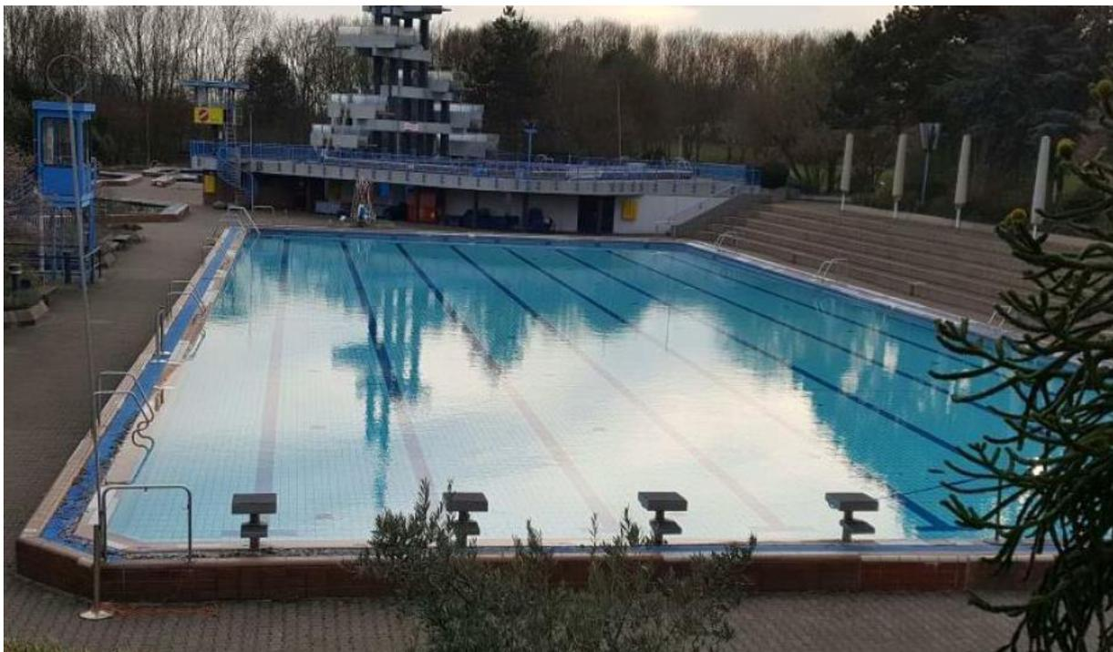
Abbildung 22: Beckenschieflage durch bergbaubedingte Einwirkungen (Quelle: Stadtwerke Gelsenkirchen „Überblick zum baulich und technischen Zustand“ vom 22.03.2017)
