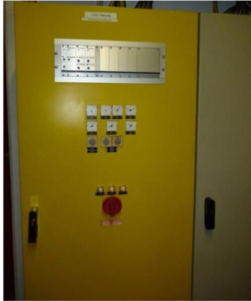
Abbildung 9: Steuerungsschrank Heizungssteuerung
