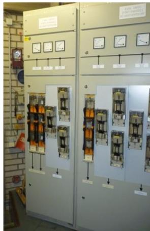
Abbildung 5: Schaltschrank mit Netztrenner
