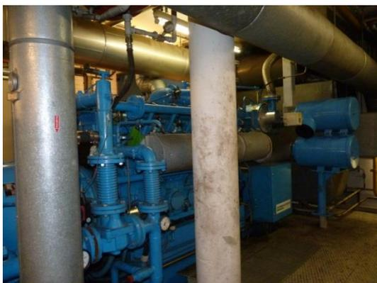
Abbildung 11: BHKW mit Gasmotor
