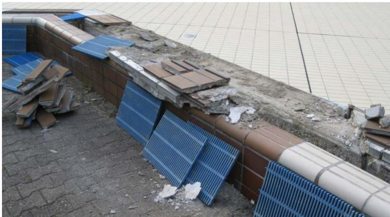
Abbildung 23: Hoher bautechnischer Sanierungsaufwand vor jeder Freibaderöffnung (Quelle: Stadtwerke Gelsenkirchen „Überblick zum baulich und technischen Zustand“ vom 22.03.2017)
