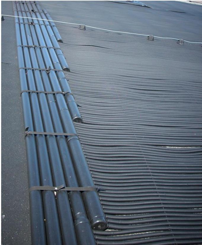
Abbildung 26: Solarabsorber auf dem Dach des Schwimmbades der Insel Juist
