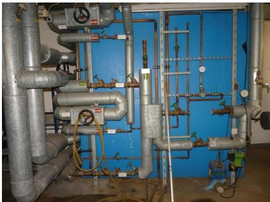
Abbildung 10: Beispiel Warmwasserbereitung
