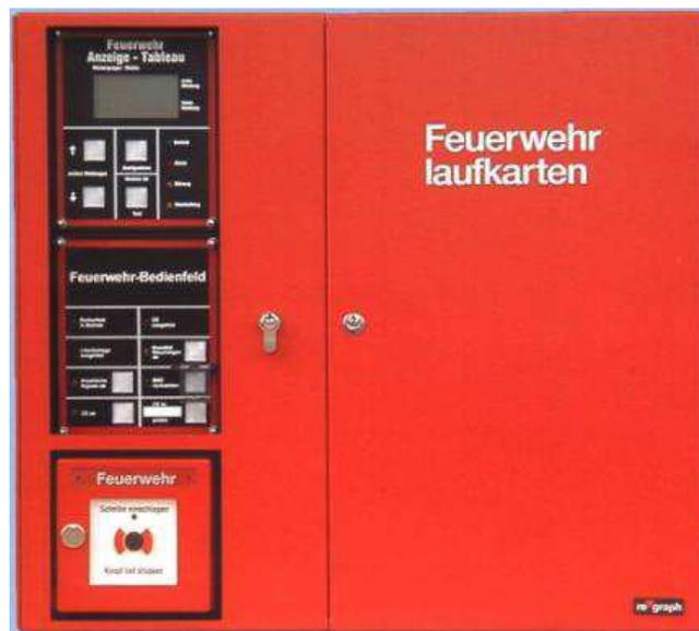
Die Feuerwehr-Informationszentrale ermöglicht der Feuerwehr im Ereignisfall den schnellen Zugriff auf alle wichtigen Bedien- und Informationsmittel wie Feuerwehr-Anzeigetabelle (FAT), Feuerwehrbedienfeld (FBF) und Meldergruppenpläne (Linienlaufkarten) in einem abschließbaren Behältnis, nur für die Feuerwehr zugänglich (ausgenommen Planfach), als kompakte Funktionseinheit.
