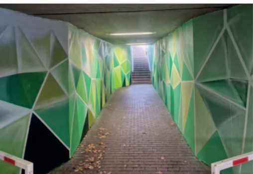
Links: Neugestaltung an der Unterführung Robert-Koch-Straße; unten: Graffiti an der Unterführung Bismarckstraße
