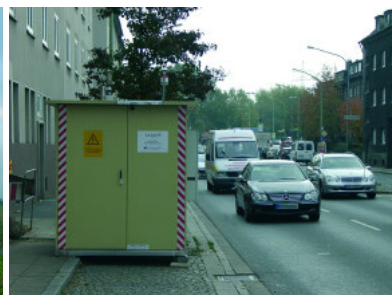
LUQS-Container kleiner Bauart (Mini-Container) zur Messung der Luftbelastung in Straßen
