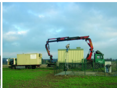
Mobiler LUQS-Container mit Transportfahrzeug
