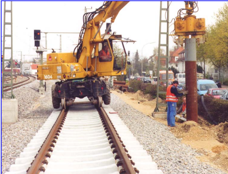
Bauen vom Gleis Zweiwegebagger, Rammrohre
