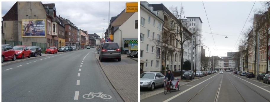
Abbildung 25: Markierung von Schutzstreifen und Radfahrstreifen für den Radverkehr auf einer 2-streifigen Fahrbahn (Neumühler Straße in Oberhausen, links und Goethestraße in Kassel mit Straßenbahnführung, rechts)
