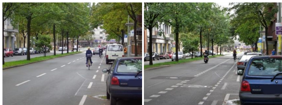
Abbildung 24: Abmarkierung von Angebotsstreifen für den Radverkehr auf einer 4-streifigen Fahrbahn (Beispiel Brandenburgische Straße, Berlin)
