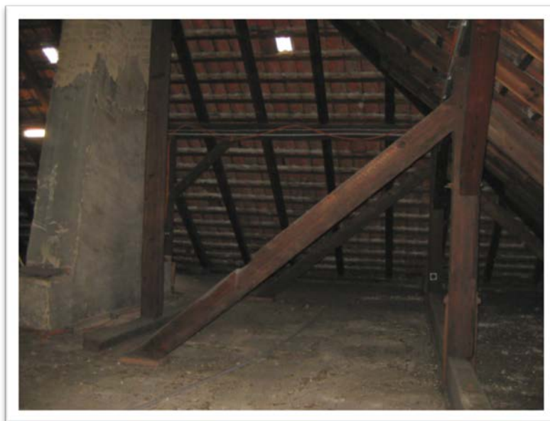
Abbildung 77: Oberste Geschossdecke und ungedämmtes Dach, Hauptgebäude der Lindenschule Buer
