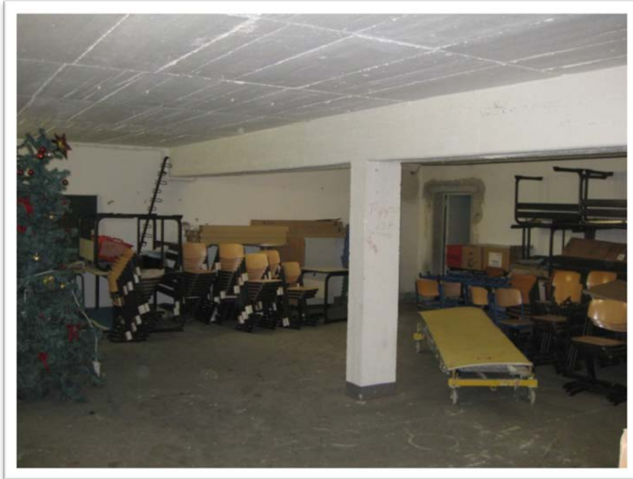
Abbildung 97: Kellerdecke des Hauptgebäudes, Schalker-Gymnasium
