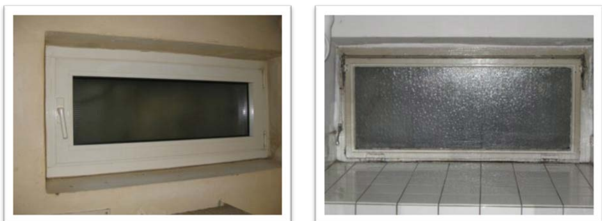
Abbildung 99: Saniertes Kellerfenster (links) und unsaniertes Kellerfenster (rechts), Schalker Gymnasium
