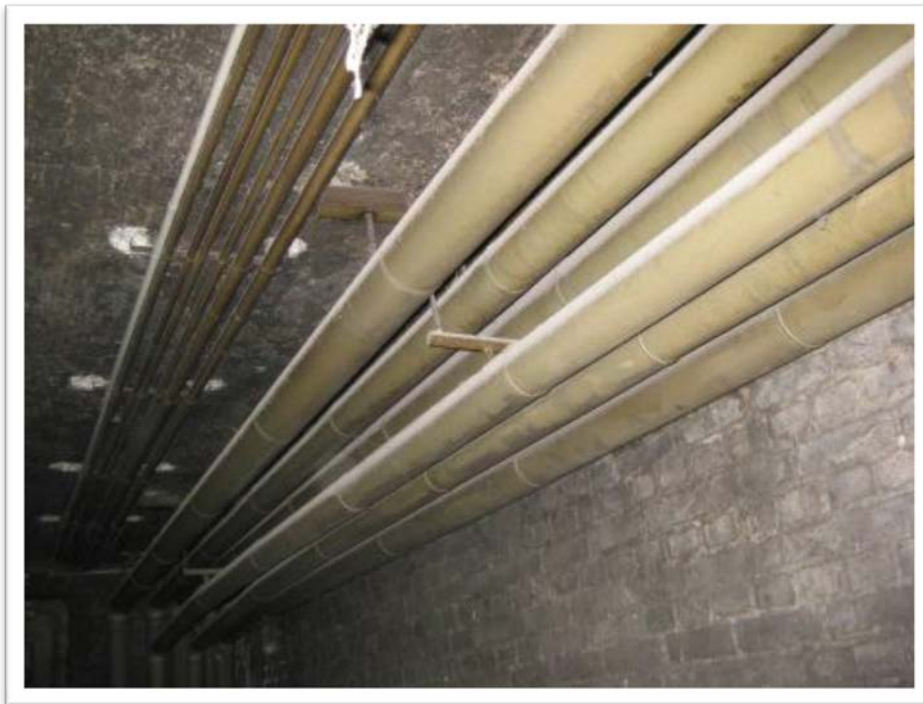
Abbildung 43: Kellerdecke des Hauptgebäudes mit Verteilleitungen, Glückaufschule-Ückendorf
