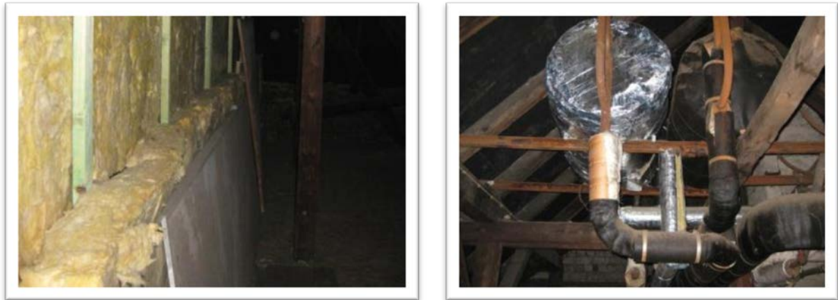
Abbildung 44: Gedämmte Außenwand zum unbeheizten Dachboden und offenes Ausdehnungsgefäß, Glückaufschule-Ückendorf
