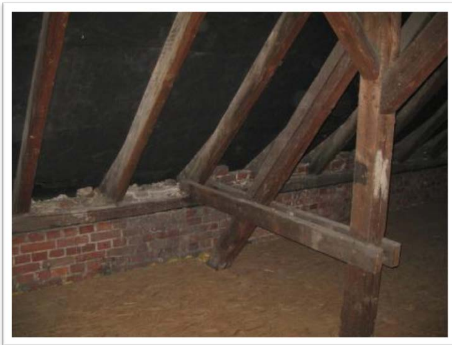
Abbildung 45: Oberste Geschossdecke zum unbeheizten Dachboden mit der nachträglichen Dämmung und Dach mit Vliesdampfbremse/ Dachfassadenbahn, Glückaufschule-Ückendorf
