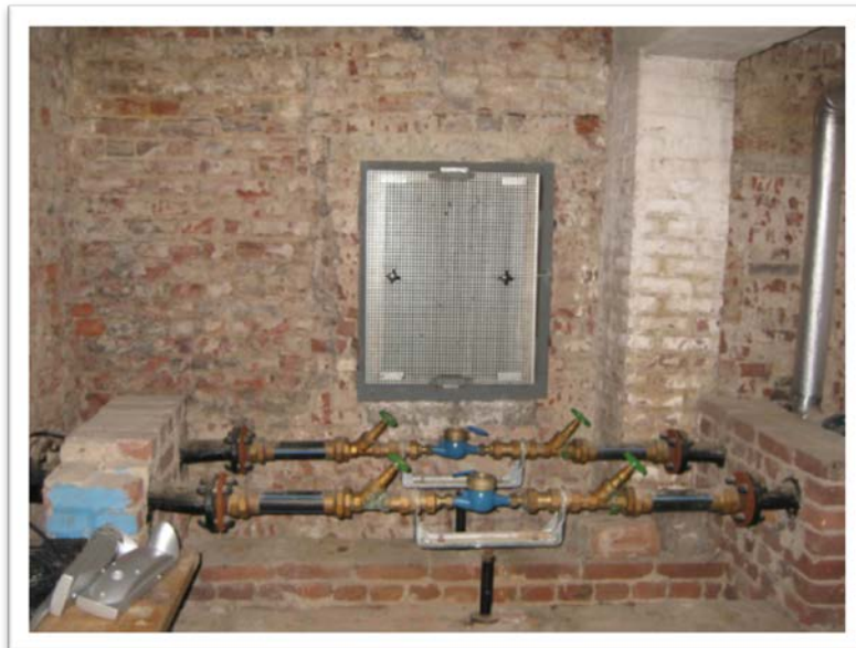
Abbildung 76: Gemauerte Kellerwände mit Vollziegeln, Hauptgebäude der Lindenschule Buer
