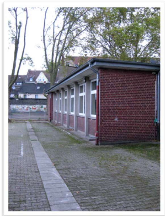
West- und Südfassade
