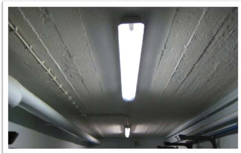
Abbildung 75: Nachträglich unterfangene Kellerdecke, Hauptgebäude der Lindenschule Buer
