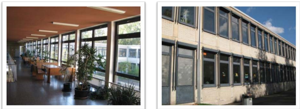
Abbildung 100: Aufstellung der Heizkörper (links) und außenliegender Sonnenschutz (rechts, Schalker Gymnasium)
