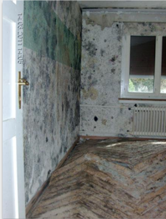
www.schimmel-im-haus.ch ; Bild: Sanawall
