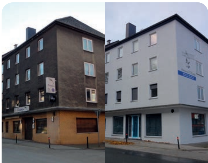
Haus und Hofflächenprogramm: Fassade an der Bahnhofstraße in Westerholt vorher - nachher
