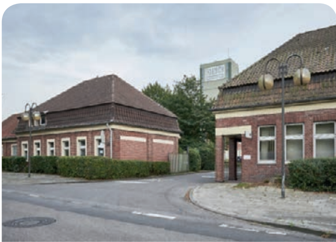
Zukünftiger Standort von Stadtteilbüro und Projektbüro Neue Zeche Westerholt: die ehemaligen Torhäuser der Zeche
