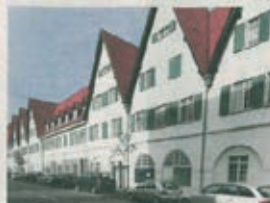
Das Programm fördert ebenfalls auch die Kirche, die eine schmale Fassade an der Geschlechterstraße zu sanieren. Der Kosten rechnet 450.000. Das Programm nur Modernisierungen über das laufende Jahr.
