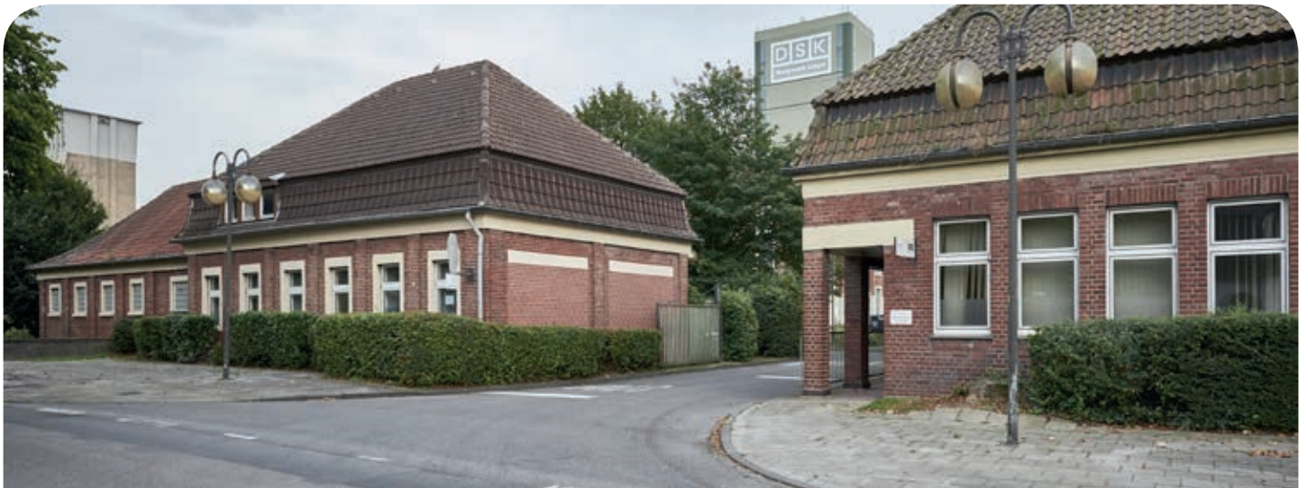
Die Torhäuser der Zeche Westerholt vor Start der Sanierungsarbeiten
