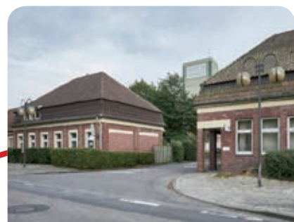
Dezember 2016 Baubeginn Torhäuser Neue Zeche Westerholt, zukünftiger Sitz von Projektgemeinschaft und Stadtteilbüro
