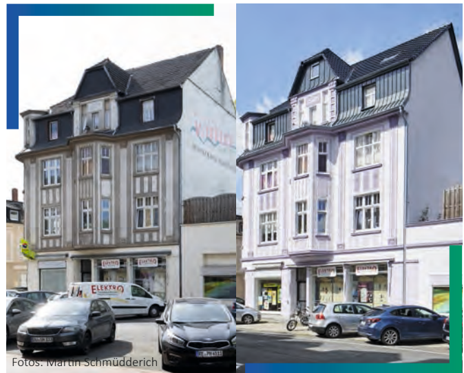
Fassade an der Bahnhofstraße in Westerholt vorher - nachher
