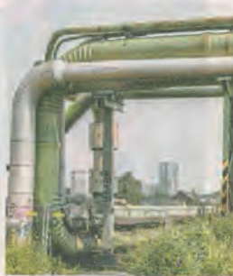
Die grünen Rohrleitungen prägen den neuen Stadtteilpark Hassel. FOTO: TS
