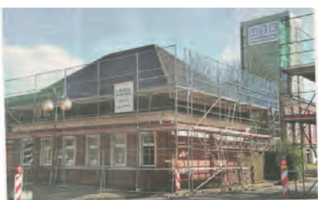
Die Fassade der ehemaligen Zeche Westerholt wurde bereits ausgiebig saniert und eingestrichen. Nach 10 Wochen soll der fertig sein.
