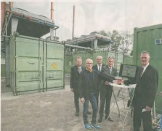
Klimafreundliche Energie kommt aus grünen Containern: Fritz Henjes (Uniper), Frank Baranowski, Gerd Wagner (Mingas) und Volker Lindner (Stadtbaurat Herten, v.l.) starten die Wärmeauskoppelung.
