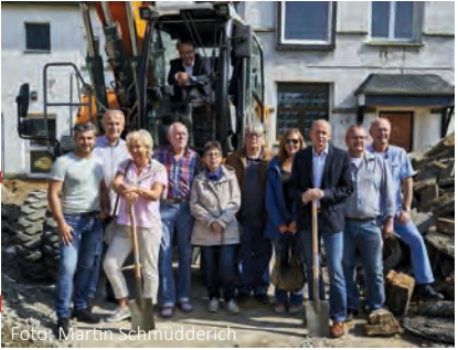
Foto: Martin Schmüderich Juni 2018 Spatenstich am Marktplatz Hassel/ August-Schmidt-Platz
