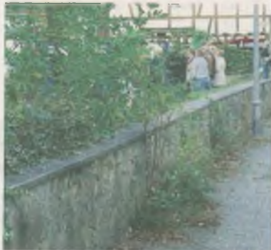
Was wird aus der Sandsteinmauer? Umstritten war Frage schon bei der Bürgerversammlung im Oktober bei dieses Foto entstand. —FOTO: MARTIN PYPLATZ
