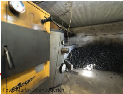
Foto: Martin Schmüderich Oktober 2015 Erste Fördermaßnahme des Energielabor Ruhr im Bestand der Zechensiedlungen: Umstellung einer Kohleheizung auf Gas
