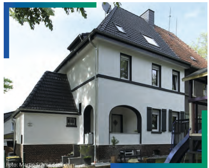
Foto: Martin Schmüdderich Saniertes Zechenhaus
