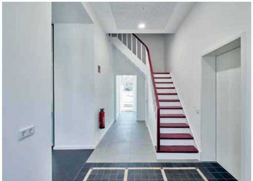
Ein Teil des historischen Fliesenbodens konnte gerettet werden.
