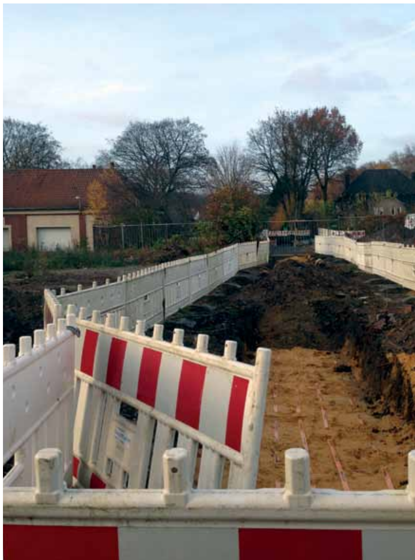
Die Nahwärmeleitungen in der Siedlung mussten neu verlegt werden.
