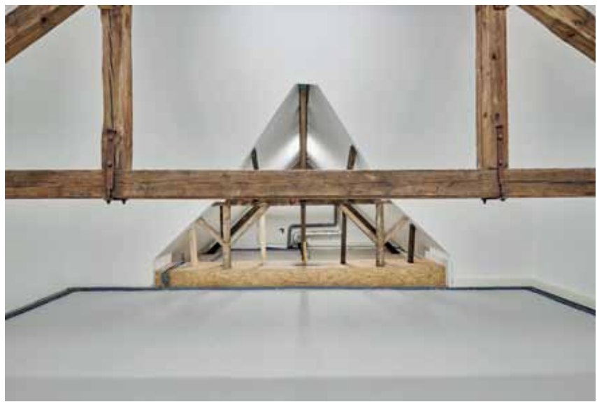
Interessante Räume schafft die Innendämmung des Dachstuhls im Torhaus 12.
