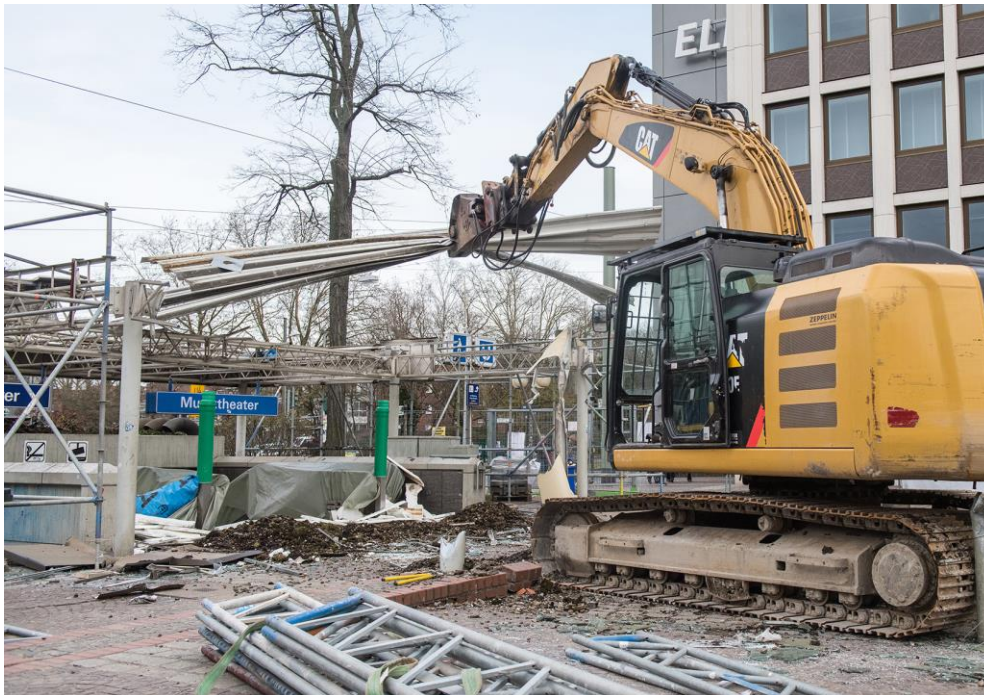
Abbildung 2: Abriss der alten Haltestellendächer (Quelle: Caroline Seidel)
