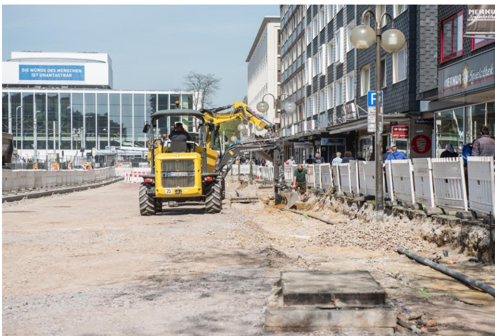
Abbildung 1: Hier entsteht bald die neue Fahrbahn der Ebertstraße (Quelle: Caroline Seidel)
