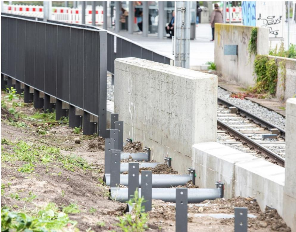
Abb.3: Zaunmontage am U-Bahn-Tunnel (Quelle: Caroline Seidel)
