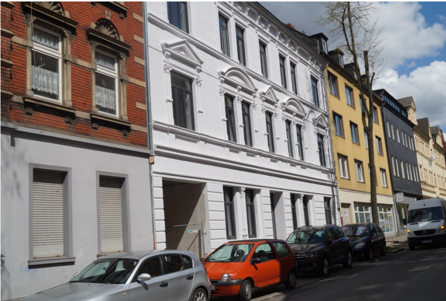
Abbildung 30: Bergmannstraße 5 nach Modernisierung
