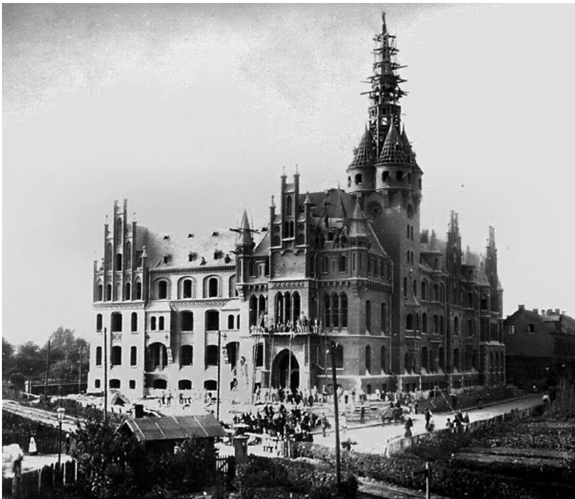
Das Gelsenkirchener Rathaus im Bau (1896)
