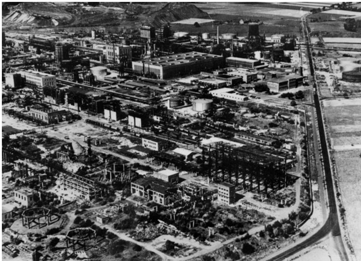
Die zerstörten Anlagen der Hydrierwerk Scholven AG (1944)
