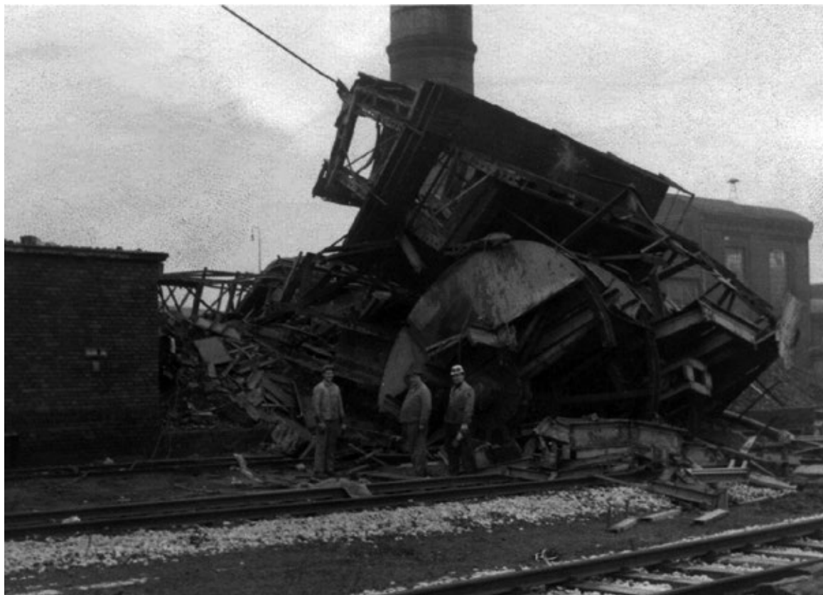
Zeche Dahlbusch, Schachtanlage 2/5/8: Umgelegtes Fördergerüst im Zuge der Demontage der Zechenanlage (1967)
