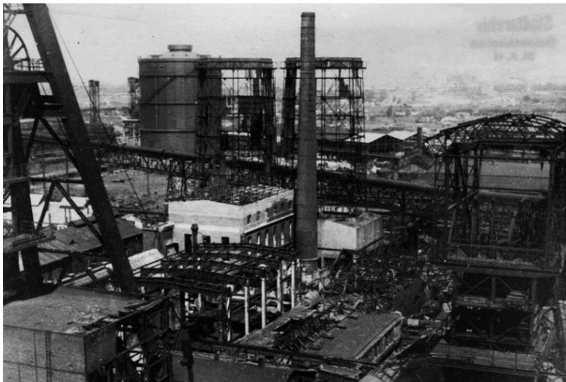
Bombenschäden am Schacht I/VI der Zeche Consolidation. Nur vergleichsweise geringe Schäden unter Tage trotz erheblicher Zerstörungen an der Oberfläche (1945)
