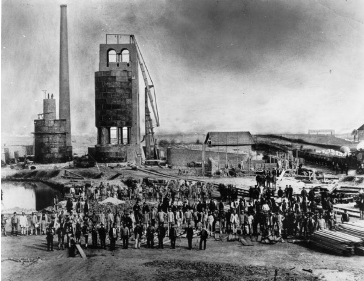
Bau der ersten Hochofenanlage des Schalker Vereins (1874)
