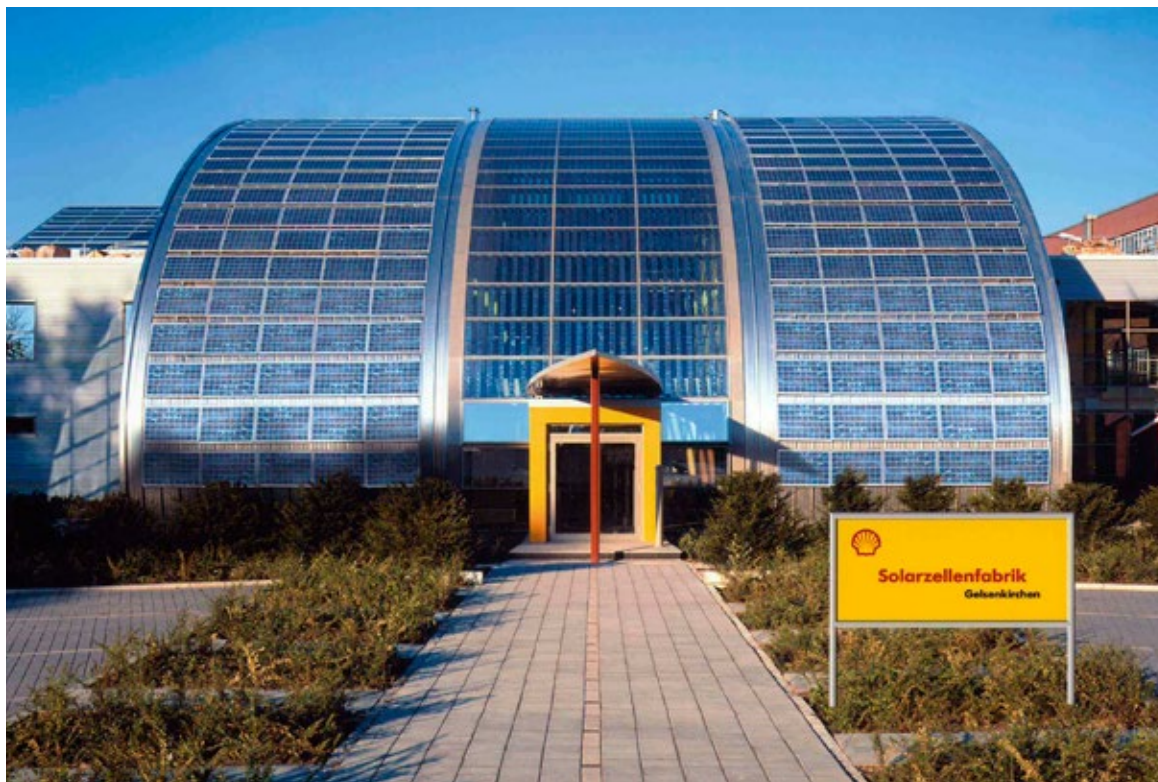
Solarzellenfabrik der Deutschen Shell AH in Rotthausen (2000)
