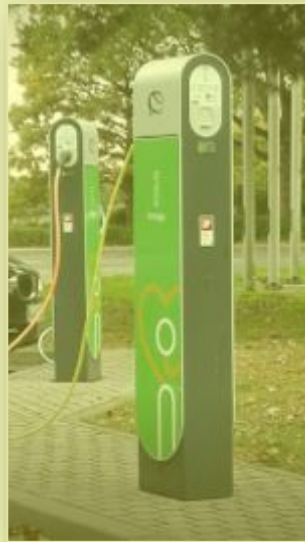
Normalladesäule Wechselstrom (AC) Ladeleistung bis 22 kW
